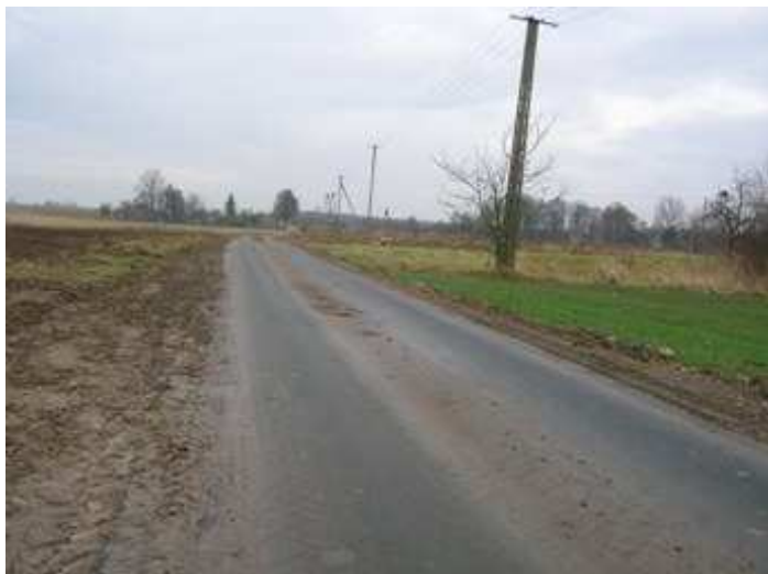
Fot. Przebudowana droga gminna w m. Ożarów
