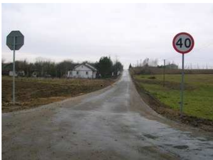
Fot. Przebudowana droga gminna w Panieńszczyźnie
