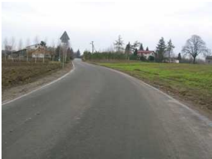
Fot. Przebudowana droga gminna w m. Marianka Ożarowska
