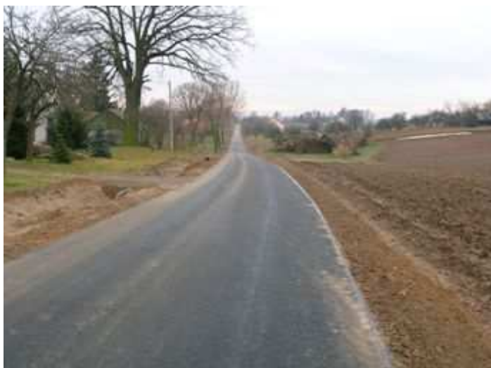
Fot. Droga gminna Panieńszczyzna-Płuszwice Kolonia
