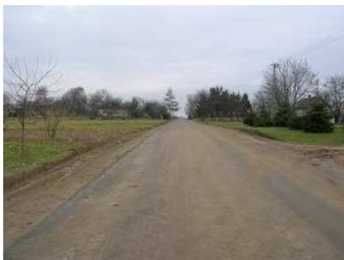
Fot. Przebudowana droga gminna Kolonia Tomaszowice-Kolonia Miłocin
